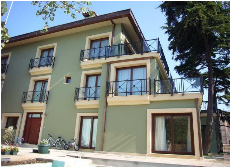
Resim 1.6: Güzel bir kâgir yapı
